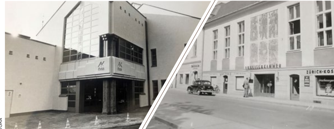
Die Bezirksstelle in Feldkirchen, eröffnet 1976, erhielt in den 1980er Jahren ein eigenes Gebäude.
